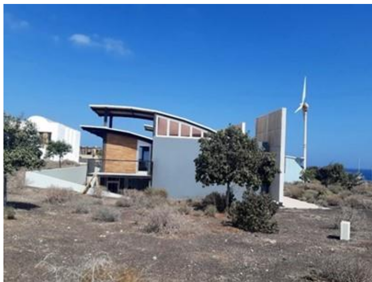
Imagen: casas bioclimáticas. Fuente: imagen tomada durante la visita
